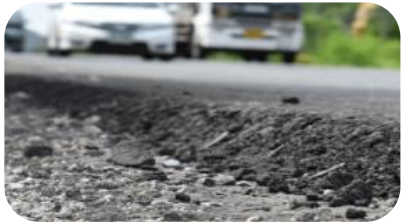
Materiale per sottofondo stradale
