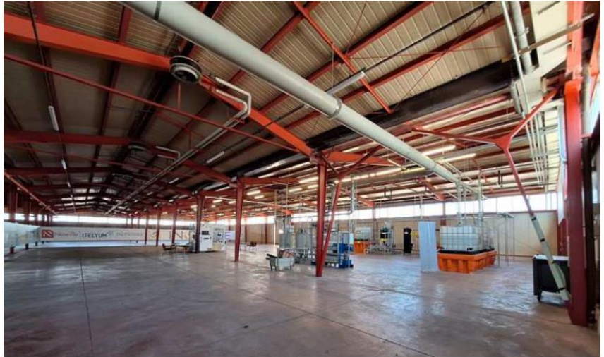
Figura 5 - Interni del capannone industriale; sullo sfondo a destra le diverse sezioni dell'impianto sperimentale
